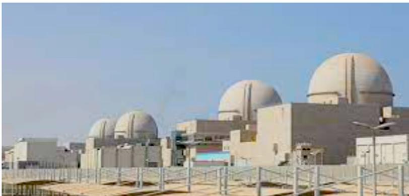
Der koreanische **APR 1400** ist ein Reaktor der Generation III mit aktiven Sicherheitssystemen. Die vier Reaktoren mit 5,6 GW Leistung sind in
