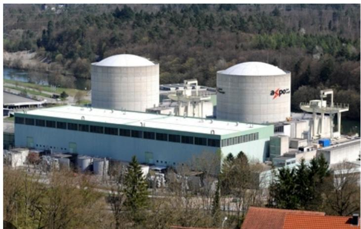
voneinander unabhängige Notkühlsysteme. Diese Systeme sind auf eine zuverlässige Stromversorgung angewiesen, bei Netzausfall durch Notstrom-Dieselmotoren. Den Reaktor umgibt eine massive, dichte Schutzhülle
